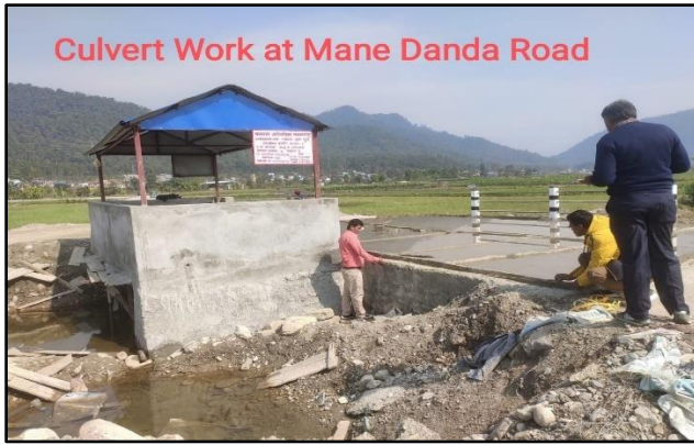
मानेडाँडा कल्भर्ट निर्माण
